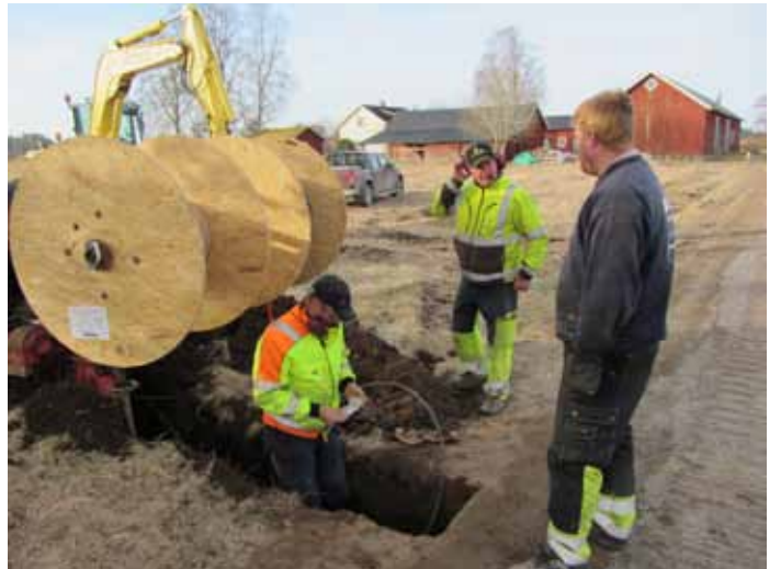
Leif Hedvall, Ander Lilja och Gustav Hellquist under grävningsarbetet i Herregården
